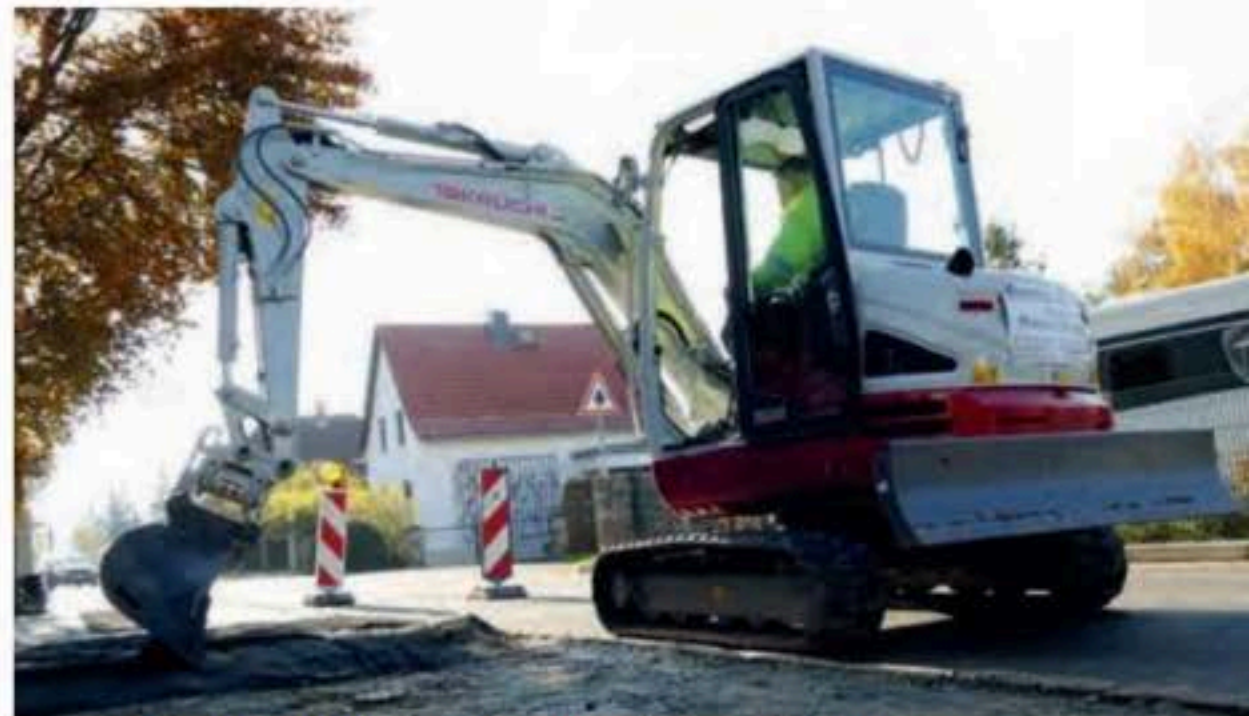
Der neue Takeuchi-Kompaktbagger TB 240 beim letzten Verfüllschritt einer sanierten Wasserleitung.
